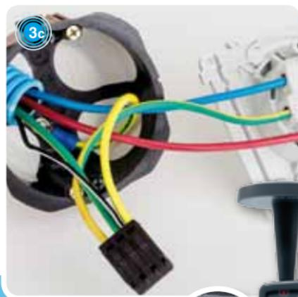
**3** Le fil semi-conducteur doit toujours être connecté à une de ses extrémités au circuit de terre v/j. Le fil semi-conducteur et le fil de terre des boîtiers d'encastrement doivent être raccordés à un connecteur automatique. Ce connecteur est ensuite relié au réseau de terre de l'installation.
